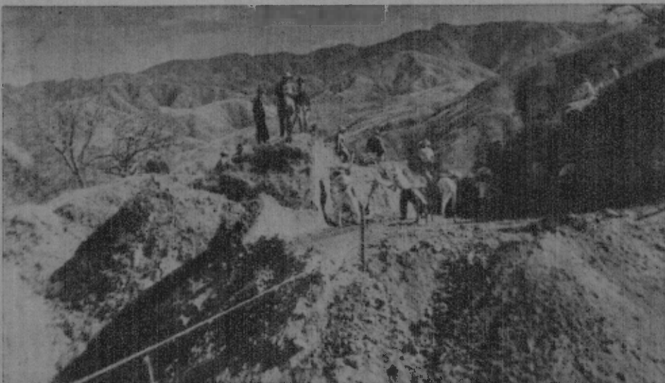
Sobre una sierra más difícil que la que atraviesa la carretera de Laredo, se ha logrado, en cuatro meses, comunicar a Guadalajara con Nayarit, adelantando en la tarea de construir una segunda carretera internacional por el occidente.
